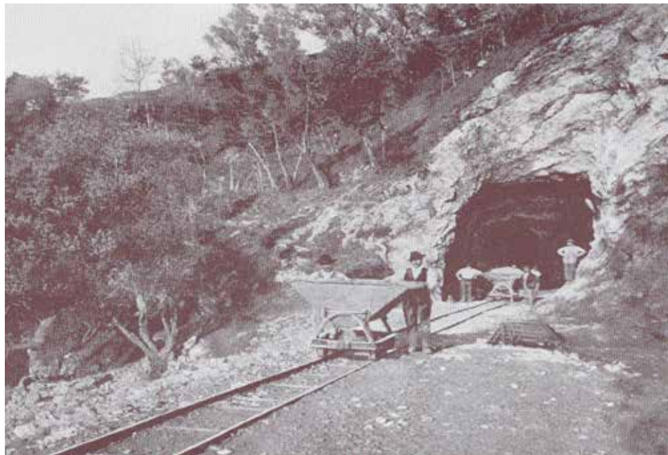
Galleria per la ferrovia in costruzione sopra Marone (1905 c.)
