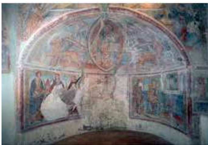
L'abside dopo il consolidamento e le stuccature
