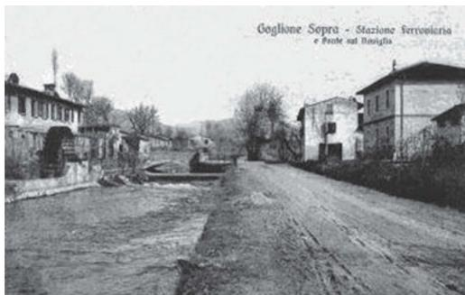
Fig. 4: Cartolina di inizio Novecento che ritrae a destra la vecchia stazione di Goglione di Sopra, e a sinistra la fucina a maglio costruita nel 1579 da Giacomo Signorini. Il corso del Naviglio è quasi a livello della strada alzaia e si può notare nell'alveo lo sfioratore che aveva la funzione di incanalare l'acqua verso la ruota idraulica della fucina costruita alla fine dell'Ottocento.
