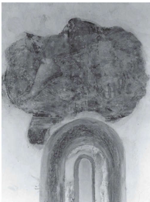
Fig. 4 - Visione dell'abside dopo il restauro.
