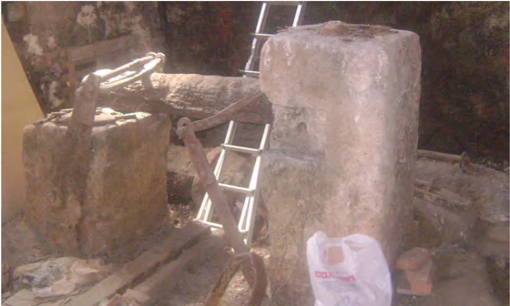
I due montanti in medolo: quello alto cm 65x80x140 più 60 cm interrati, peso 2.800 kg; quello piccolo cm 65x80x80 più 60 cm interrati, peso 1.950 kg.
