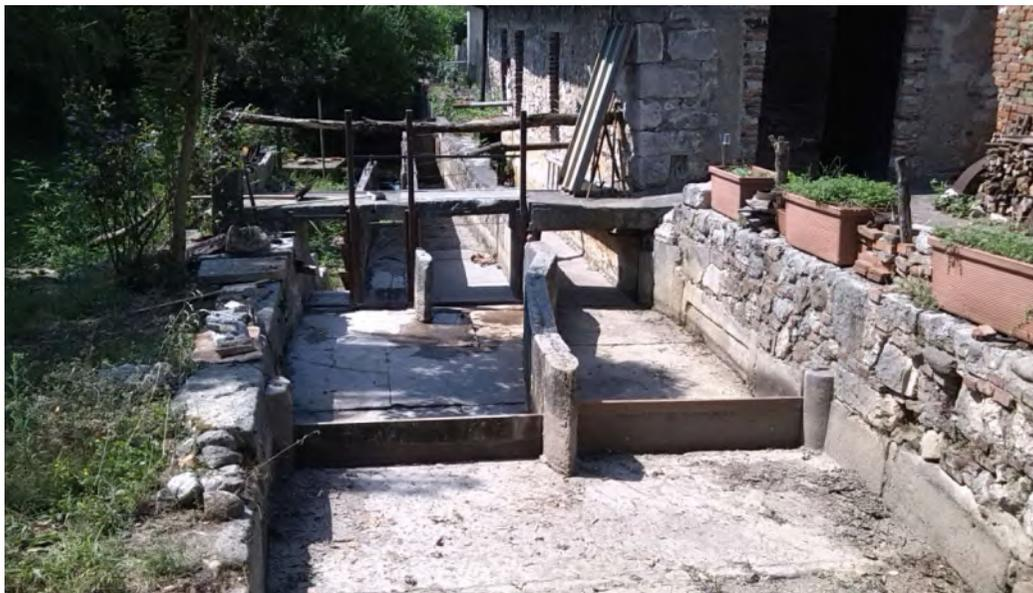
Quattro paratoie, manovrate con mulinelli e catene, bloccano lo scorrere dell'acqua nelle canalette precipiti delle ruote e quando tutte sono abbassate creano una scorta d'acqua con una gora che arriva fino al ponte delle catene.
