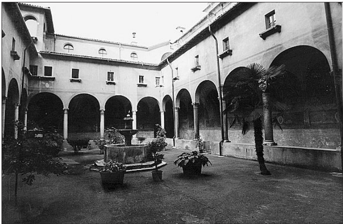
La sede della Fondazione Civiltà Bresciana
