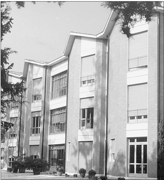
La Casa di riposo «Evaristo Almici» di Rezzato
