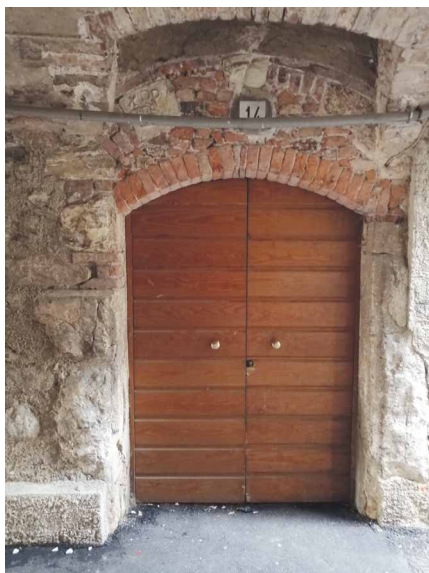
Fig. 7. Edificio di via Mossi 14, portale sud (con iscrizione nell'arco).
